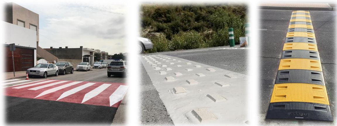
Figura 48. Elementos reductores de la velocidad en vías urbanas y periurbanas.
